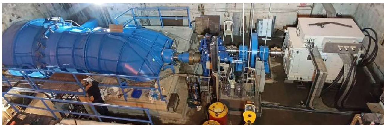
Remise en service progressive de l'usine hydroélectrique de Bongolo.
