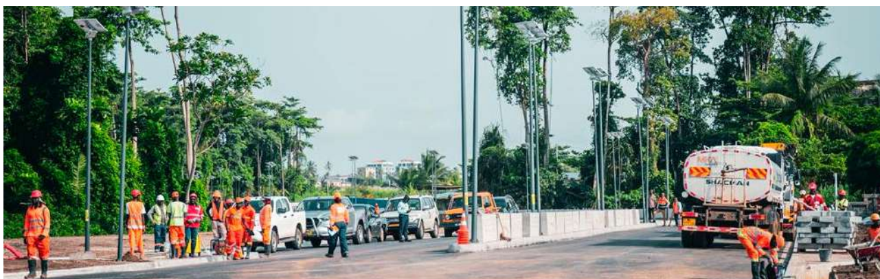
Réorganisation et la rénovation de la voirie dans le quartier Bas de Guégué remaniée jusqu'à Prix-Port, offrant de nouvelles connexions vers Mayena et Saoti.
